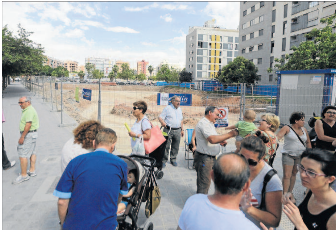
Los vecinos contrarios al centro de Casa Caridad hacen turnos en el solar de las obras. FERNANDO BUSTAMANTE
