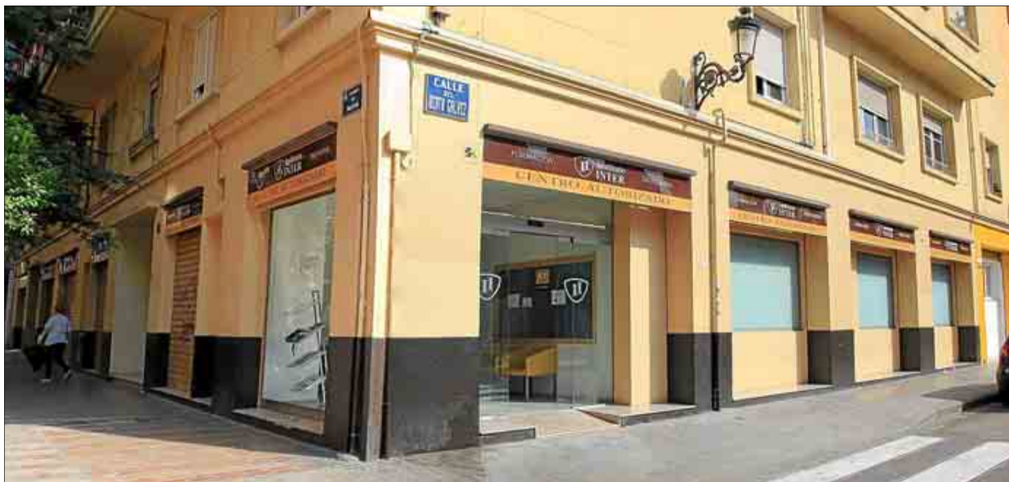
Fachada de las instalaciones del Instituto INTER en la ciudad de Valencia. / E. M.
